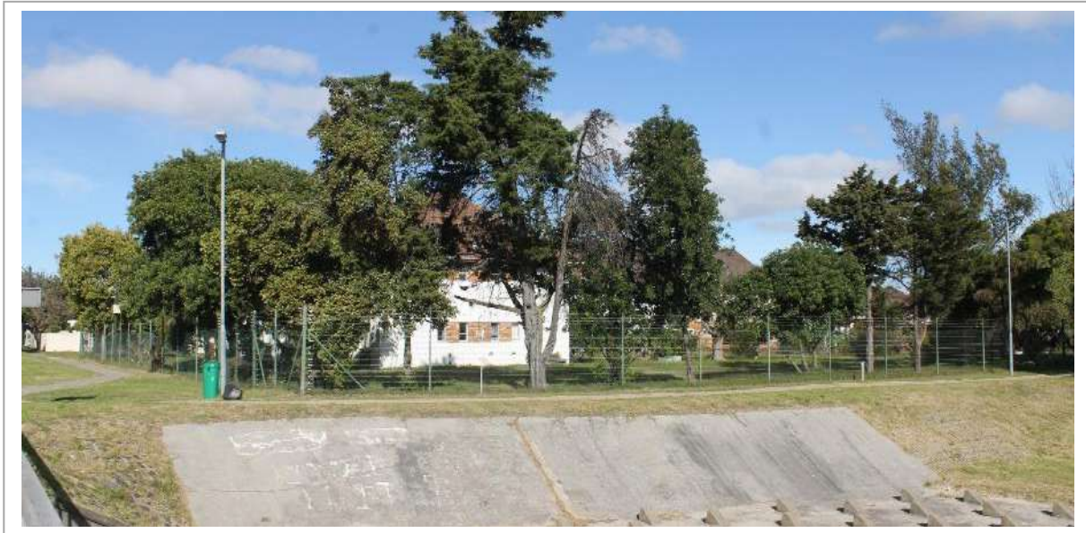
Photo 4: The existing Elsiekraal Canal edge
